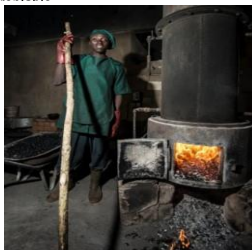
Utilisation de la coque de noix de cajou pour la production d'énergie dans le processus d'étuvage. Source : ComCashew
